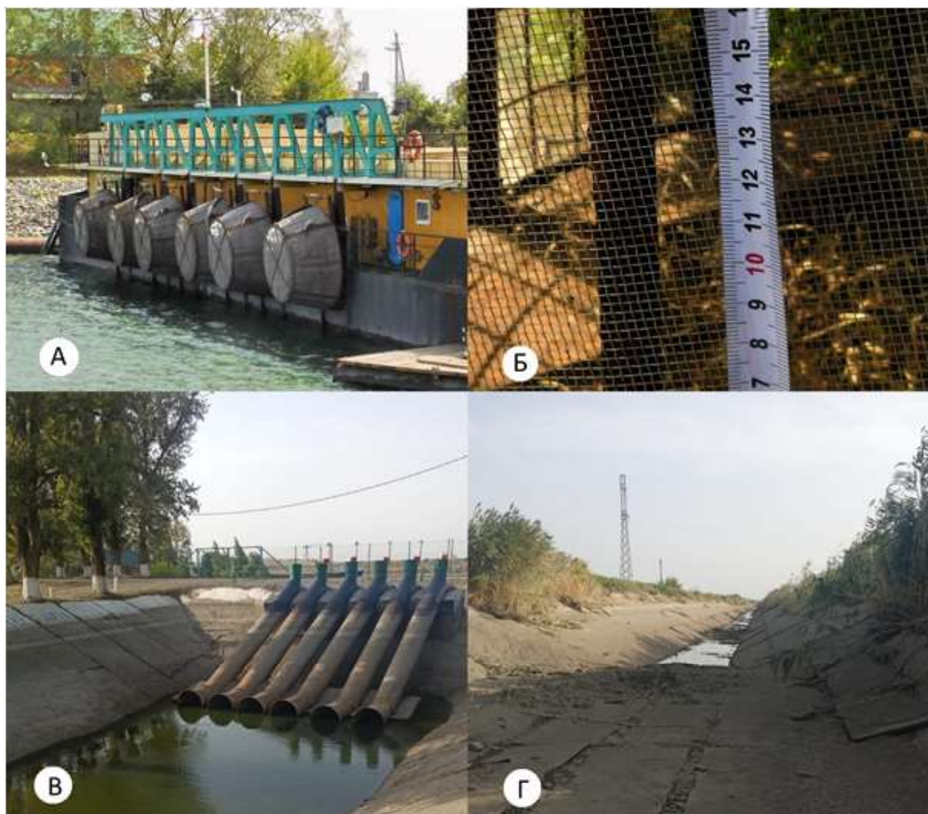
Рис. 1. А — плавучая насосная станция, осуществляющая подачу воды из р. Дон с фильтрующими барабанами рыбозащиты; Б — сетка фильтрующего барабана; В — начало магистрального канала после прекращения его работы; Г — осушенное русло магистрального канала
